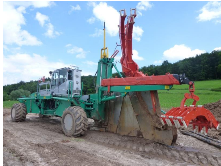
Der Pflug zum Einpflügen der Erdkabel
